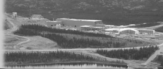
Voisey's Bay construction site
